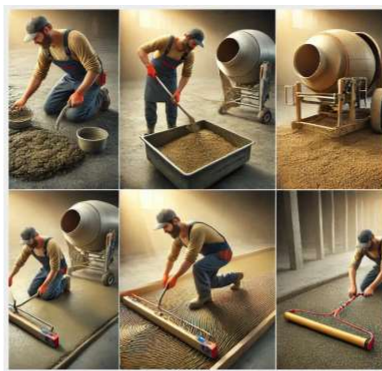
Fig.85. Procesul de realizare a șapei din mortar semiumed
