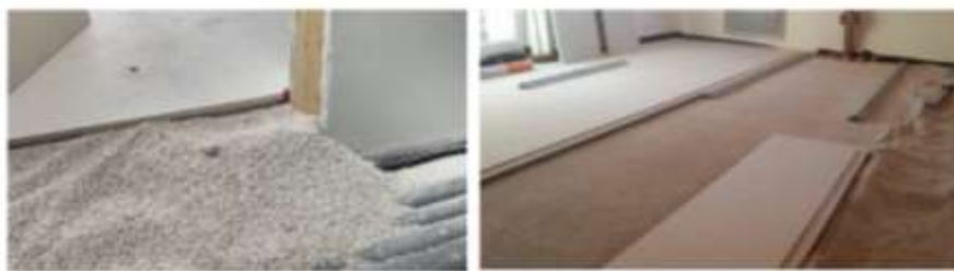
Fig.99. Șapă uscată cu plăci din fibrociment
