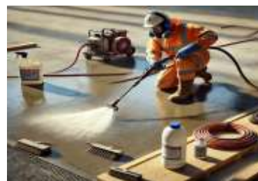
Fig.48. Curățarea suprafețelor
