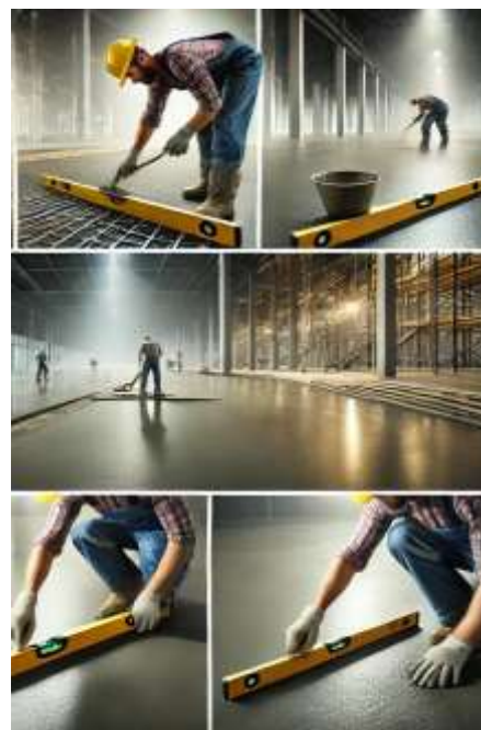
Fig.27. Nivelarea și finisarea suprafeței
