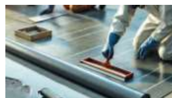
Fig.52. Verificarea și protejarea stratului termoizolant
