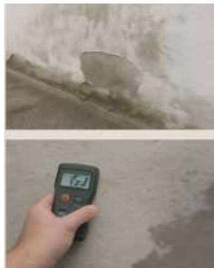
Fig.39. Umiditatea excesivă
