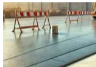
Fig.64. Uscarea și protecția stratului hidroizolant
