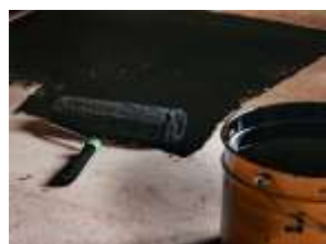
Fig.63. Aplicarea masticului
